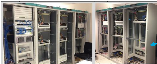
Armoires du Contrôle Commande réel
